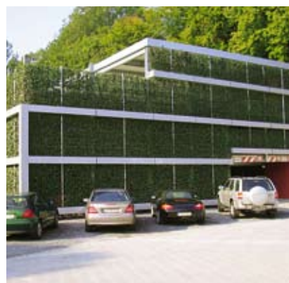
Parkeergarage in Duitsland
