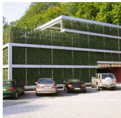
Parkeergarage in Duitsland
